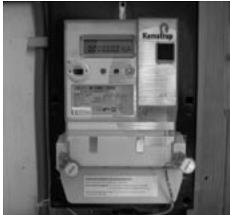
(Slimme) Elektriciteitsmeter met GSM
