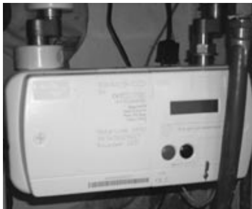
(Slimme) Gasmeter gekoppeld aan die v.d. electra
