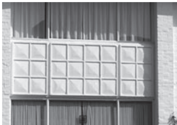
Borstwering gevel en aansluitende ramen
