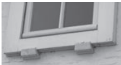
Siersteunen raam dakkapel voorgevel
